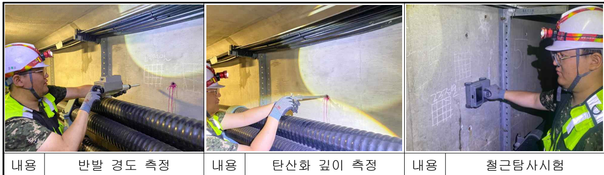
【사진 2.4】 별내인출 전력구 재료시험 전경
